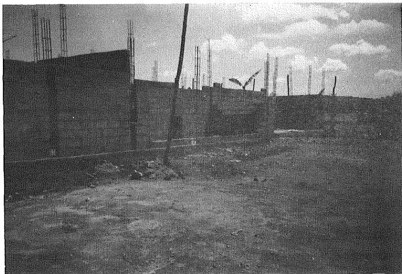
Melkfabriek in aanbouw.
